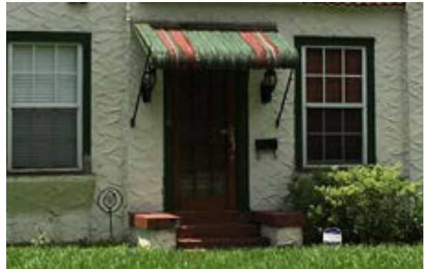
Metal Entry Door Awning
